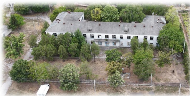
Figure 21. здание бывшей больницы
