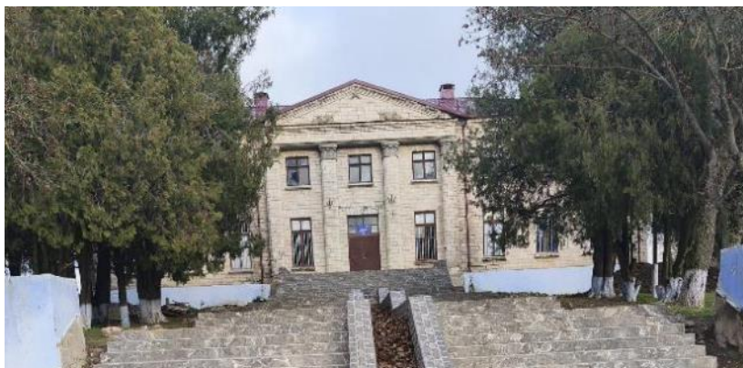
Figure 49. Вид фасада Дома Культуры Sursa: Primăria Cioc Maidan
